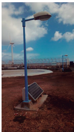
Figura 27. Farola Fotovoltaica en zona rural
