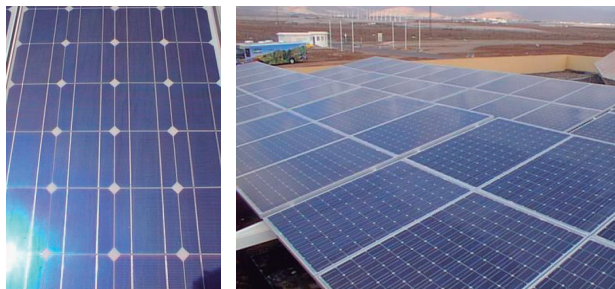
Figura 25. Panel fotovoltaico monocristalino y planta fotovoltaica instalada en cubierta
